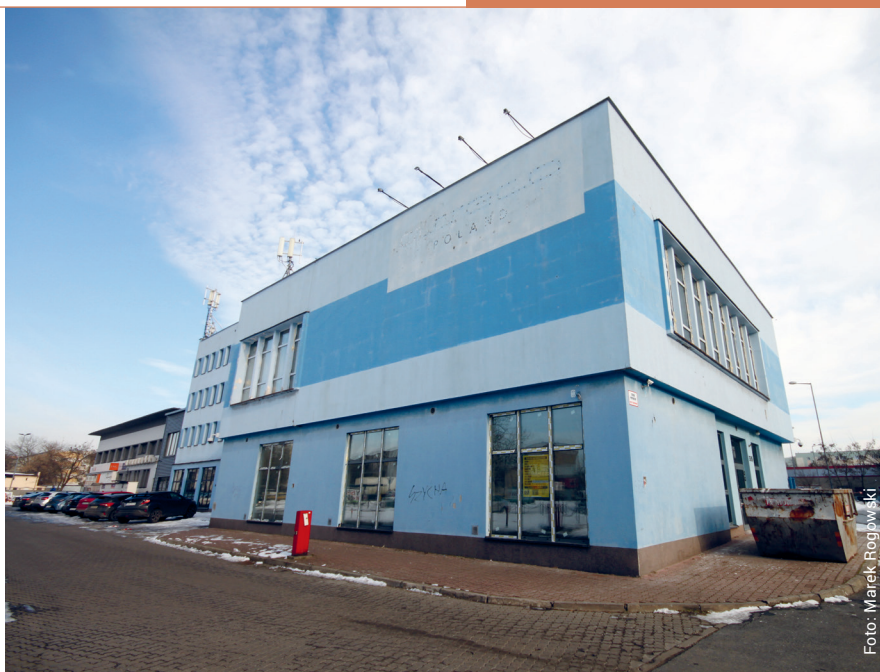
Fasada nowego obiektu BIL jeszcze przed renowacją
